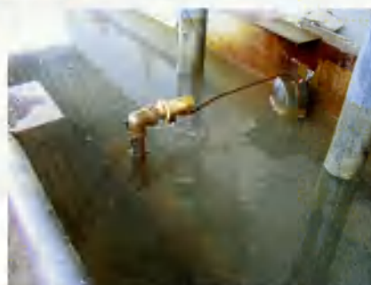
Клапанный механизм с поплавковой системой
